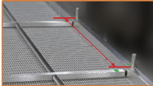
2. Anzeichnen: Die Bohrabstände auf gewünschter Seite der Profilrampe auf Ober- und Unterseite übertragen.
