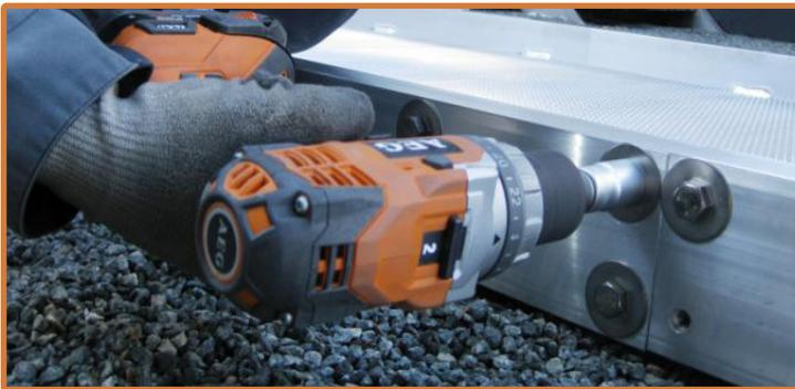
3. Auflage komplett auf die oberste Stufe auflegen, die Stütze für die Rampe befestigen und Höhe einstellen.
