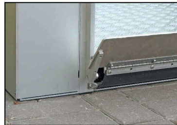
Abb. 4: Plattform in unterster Stellung, Auffahrklappe liegt auf dem Boden auf (links); Auffahrklappe ist nach oben geschwenkt (rechts).
