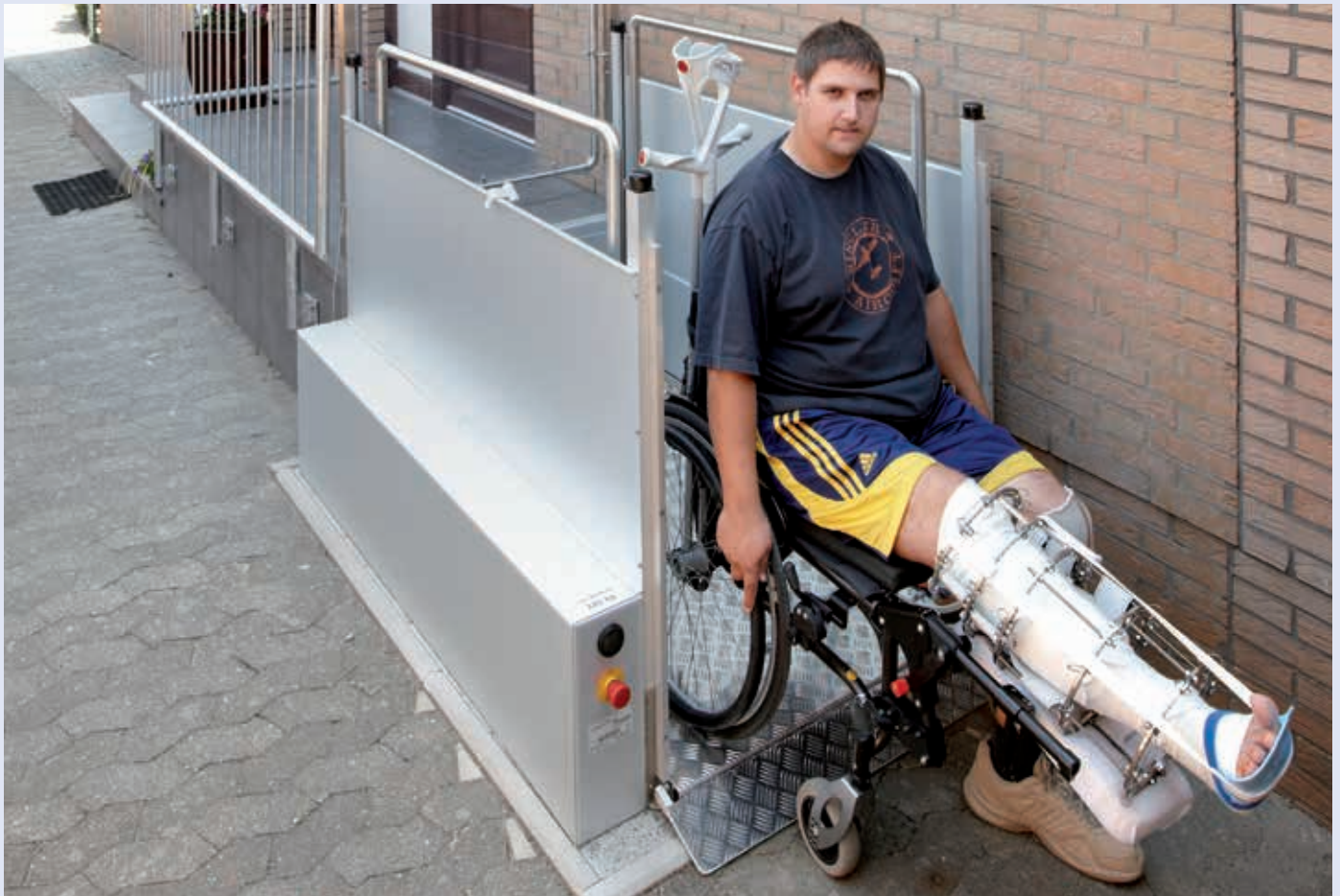
Si è dovuto ovviare agli spazi ristretti all'ingresso del cortile
