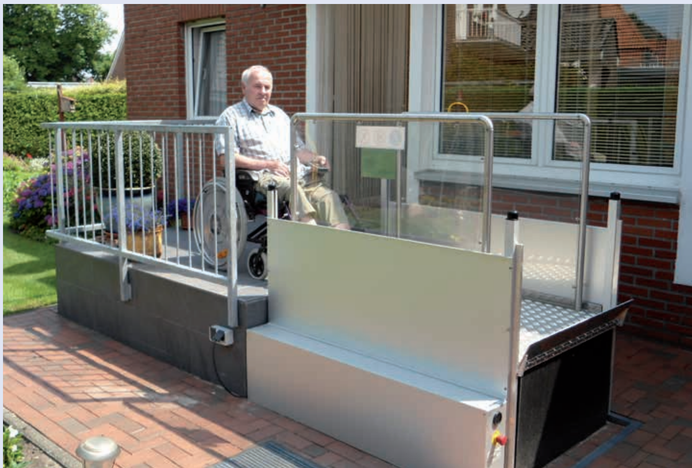
La terrazza ha offerto le migliori condizioni per l'accesso alla piattaforma elevatrice
