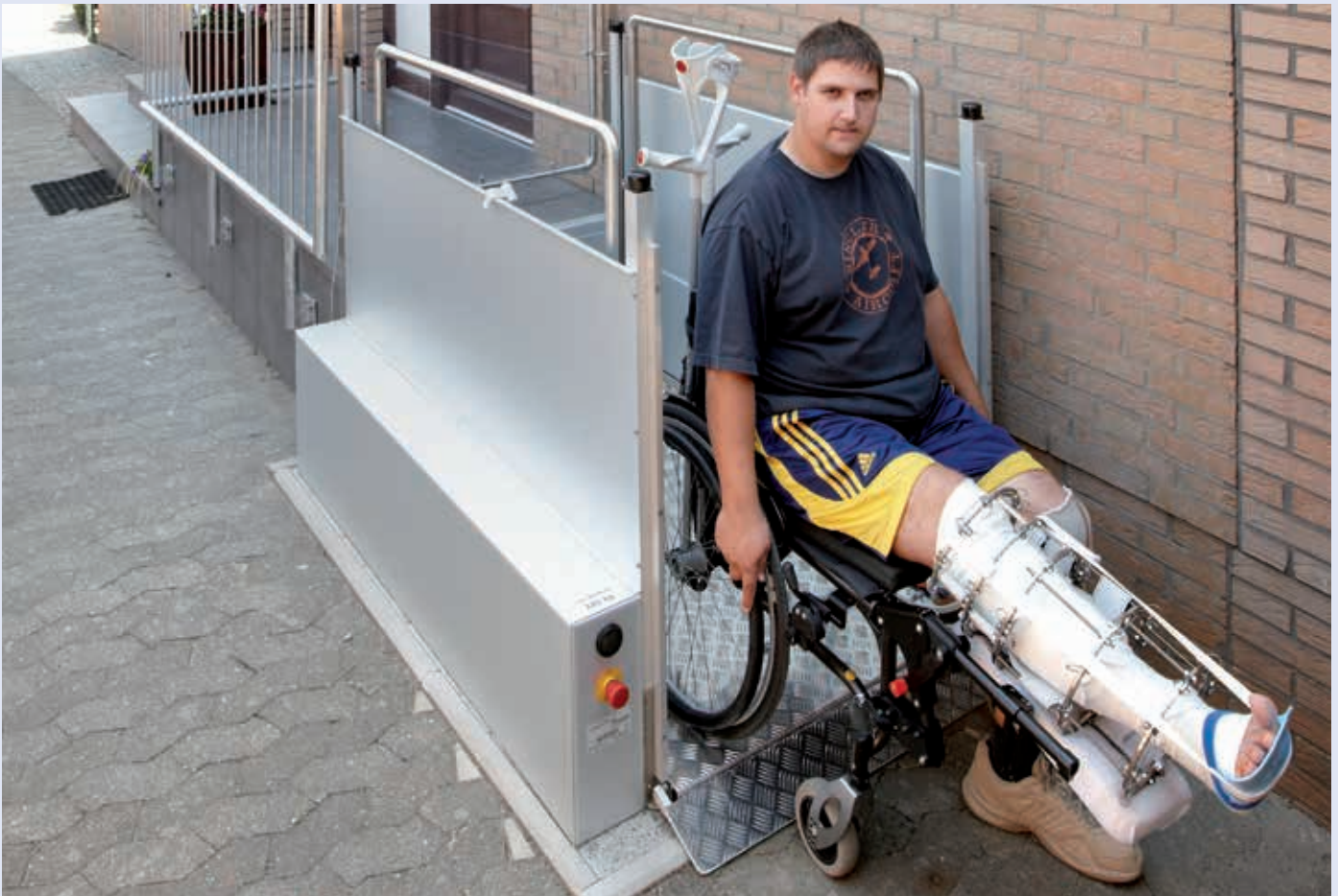
Die beengten Platzverhältnisse auf der Hofeinfahrt mussten gemeistert werden
